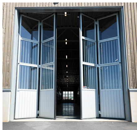
Vikport, 4-delad, med tre rader glas och galler på insidan.
