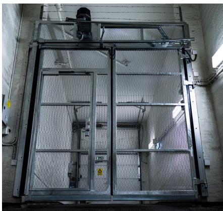
Dubbla portar med slussfunktion och infälld gångdörr för utrymning.
