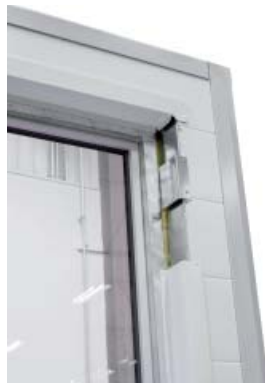
Infästning plåtvinkel
