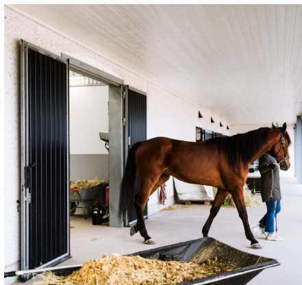
Slagport med svartlackerad profilplåt.
