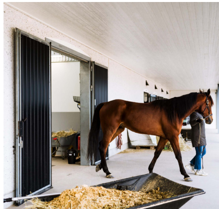
Slagport med svartlackerad profilplåt.
