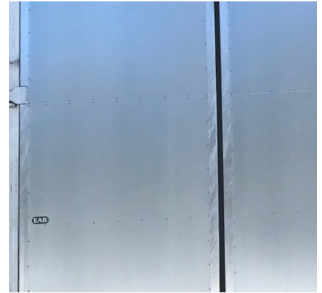
Säkerhetsvikport, invändigt beklädd med varmförzinkad slätplåt.
