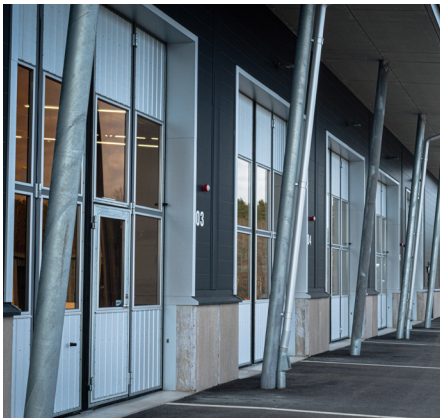
Vikportar, 4-delade, med infälld gångdörr för extra utrymningsväg och gångpassage.
