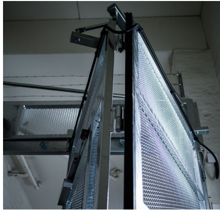
Sträckmetallnät släpper igenom ljus och ger en ökad sikt i garaget, fördelaktigt vid sluss.
