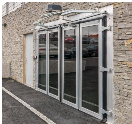
Helglasad, 4-delad, maskindriven vikport. Designline-utförande i parkeringsgarage.
