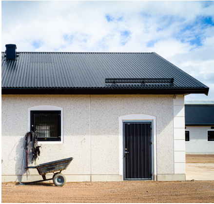
Enkel slagport i svartlackerad profilplåt.
