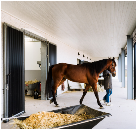
Svartlackerad slagport, profilplåten är lätt att byta vid eventuell skada.
