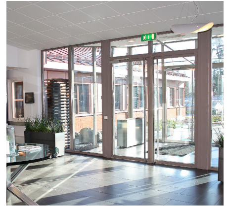
Glasad entré med grålackerade stålstommar, naturligt ljusinsläpp.
