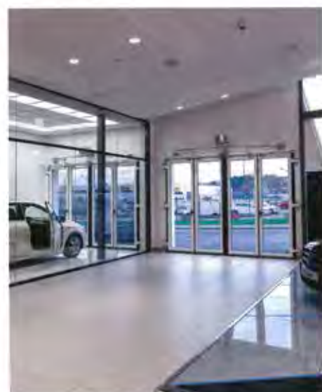
Handdriven helglasad vikport med infälld gångdörr hos Västbo Transport i Smålandsstenar. Foto: EAB
