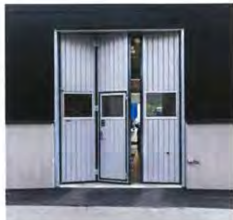
Tredelad vikport med infälld gångdörr och en rad glas hos Nybergs Bil i Nässjö. Foto: EAB
